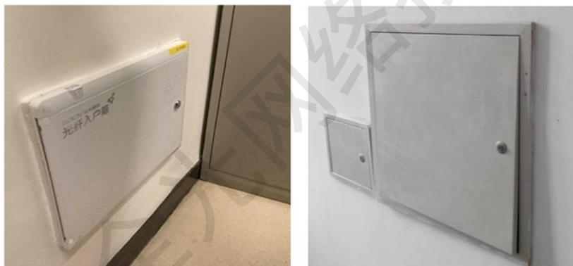
图 5-6 ONU 放置于暗装信息配线箱内的安装方式
