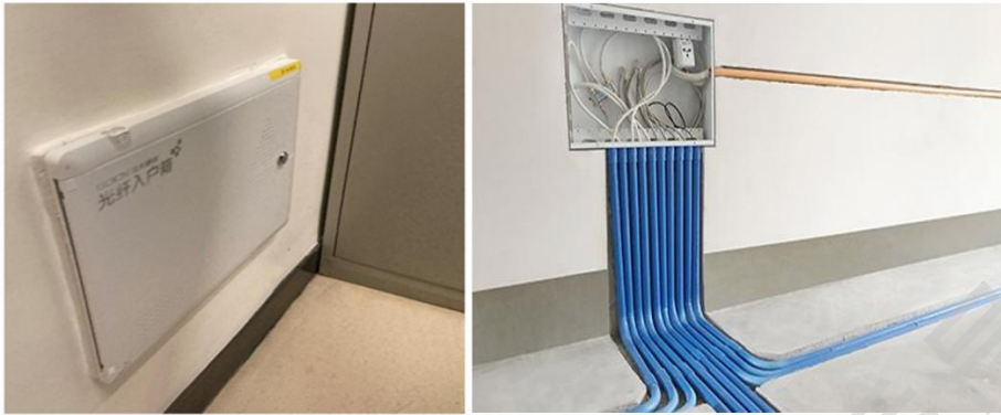
图 3-7 信息配线箱的安装与走线
