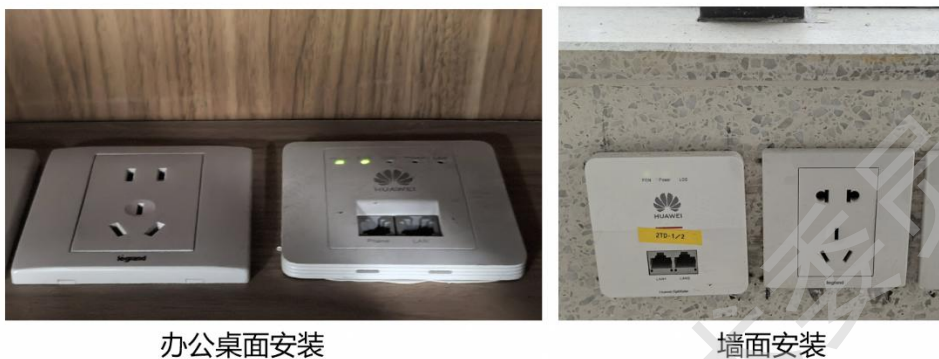
图 3-9 86 面板型 ONU 的安装
